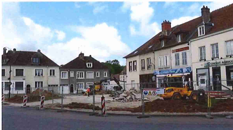
Il ne reste plus rien des anciens aménagements inadaptés de la place Croala.
